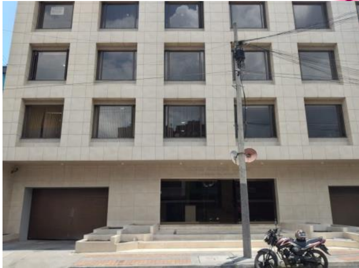
Edificio Montreal Center
